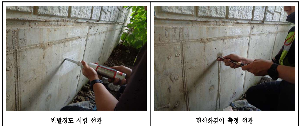
【사진 39.4.1】 콘크리트 내구성조사 현황
