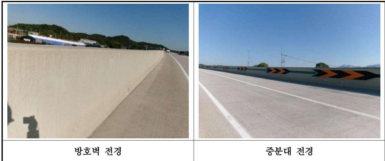
【사진 39.3.23】 방호벽 및 중앙분리대 전경
