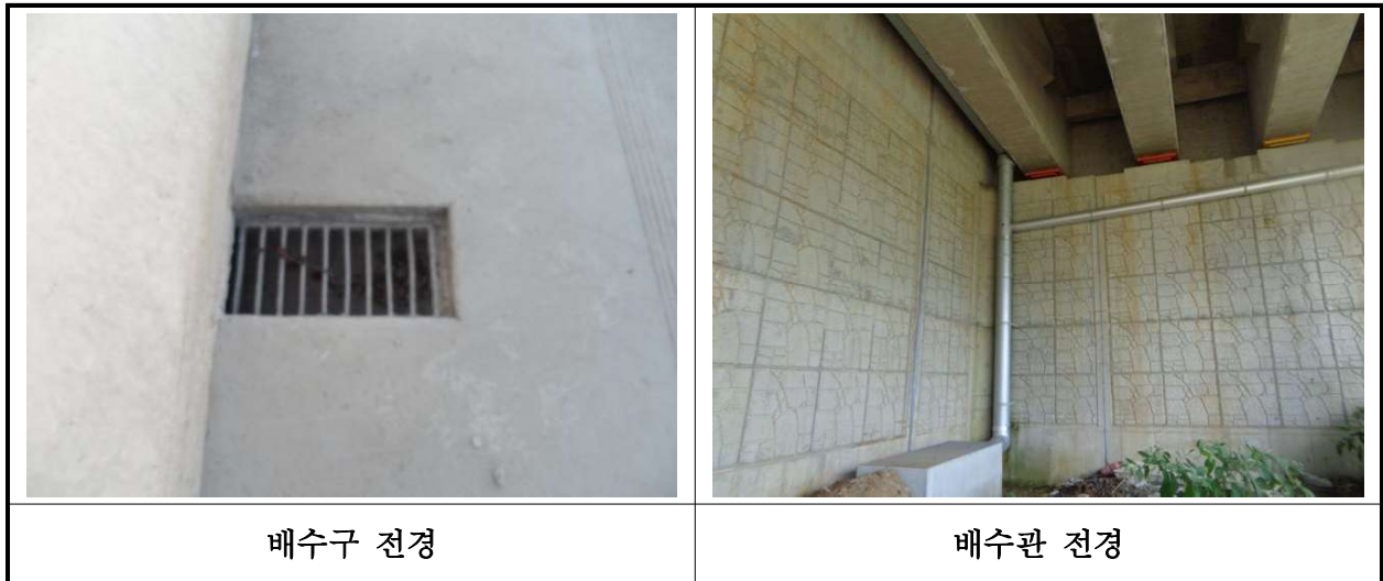
【사진 39.3.21】 배수시설 전경
