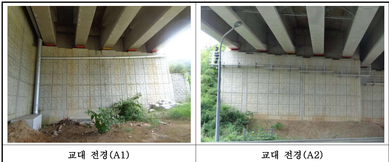
【사진 39.3.8】 교대 전경
