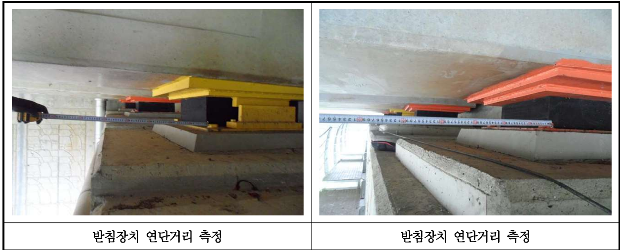
【사진 39.3.14】 교량받침장치 연단거리측정
