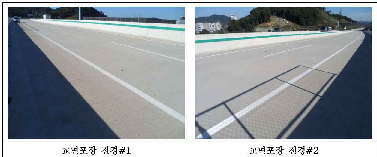
【사진 39.3.19】 교면포장 전경
