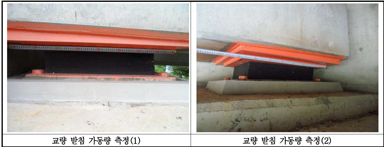
【사진 39.3.15】 교량받침 이동량 측정
