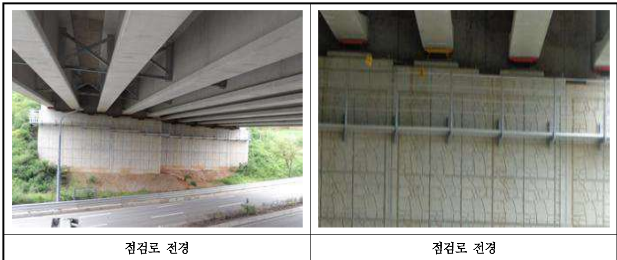
【사진 39.3.25】 교량 점검시설 전경
