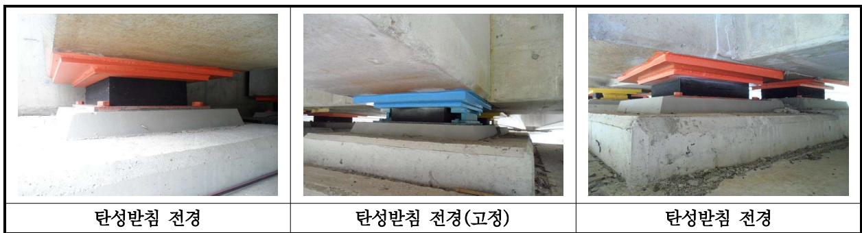
【사진 39.3.12】 교량받침 전경
