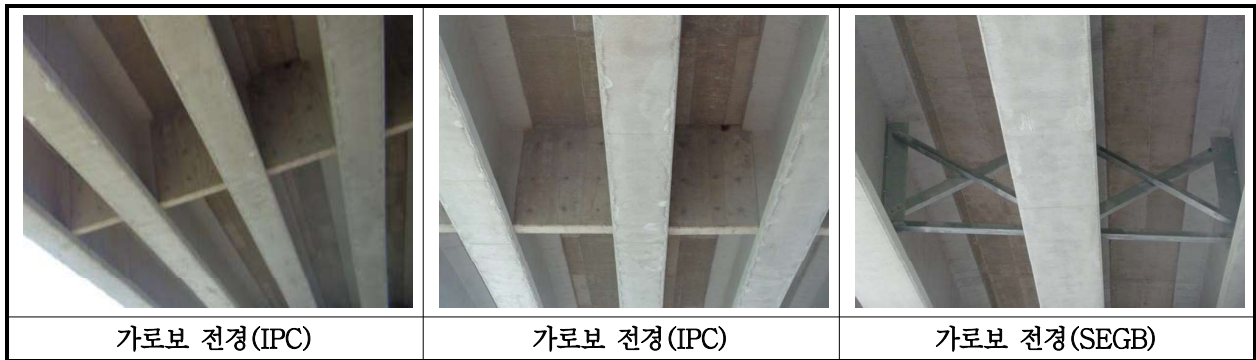
【사진 39.3.6】 가로보 전경
