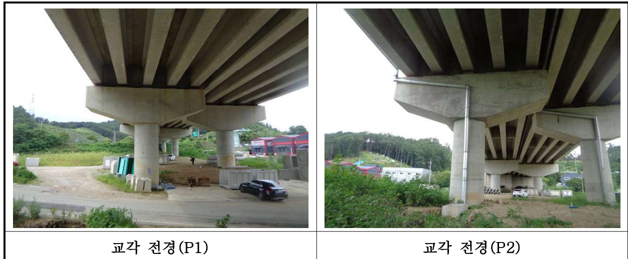
【사진 39.3.10】 교각 전경
